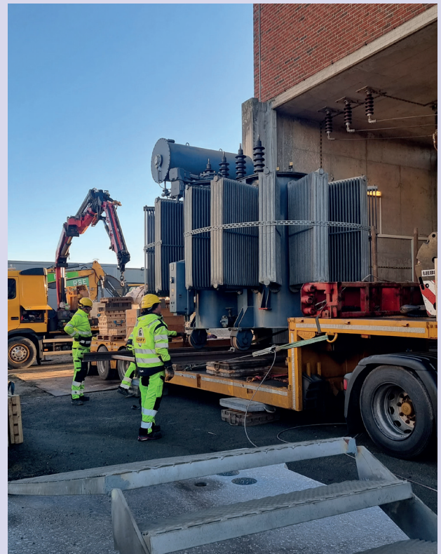
Transformator hentes ut av Øra Transformatorstasjon for å gjenbrukes
